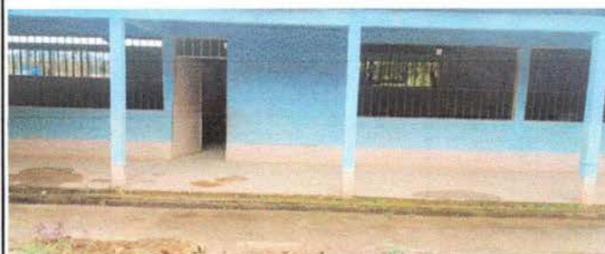
MODULO No. 2 CAMBIO DE LAMINAS Y REPINTAR NUEVAMENTE LAS PAREDES
