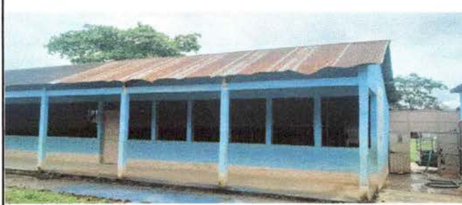
MODULO No. 2 CAMBIO DE LAMINAS Y REPINTAR NUEVAMENTE LAS PAREDES
