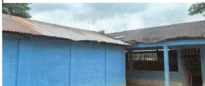
MODULO No. 3 CAMBIO DE LAMINAS Y REPINTAR NUEVAMENTE LAS PAREDES
