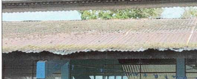
MODULO No. 1 CAMBIO DE LAMINAS Y REPINTAR NUEVAMENTE LAS PAREDES
