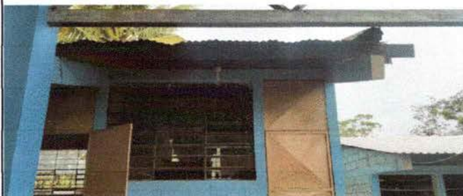
MODULO No. 1 CAMBIO DE LAMINAS Y REPINTAR NUEVAMENTE LAS PAREDES
