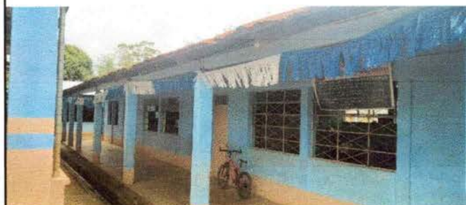
MODULO No. 3 CAMBIO DE LAMINAS Y REPINTAR NUEVAMENTE LAS PAREDES
